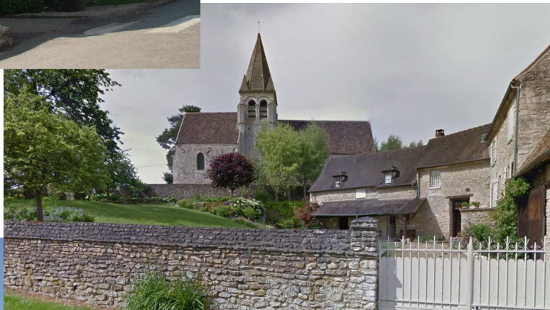
Vue de l'Eglise depuis la rue du Réveillon
