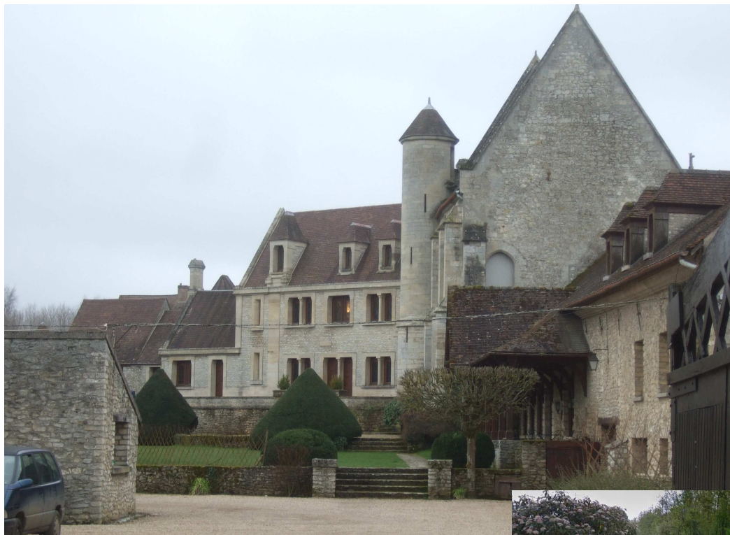
Abbaye Saint-Germer, située au cœur du centre ancien du village
