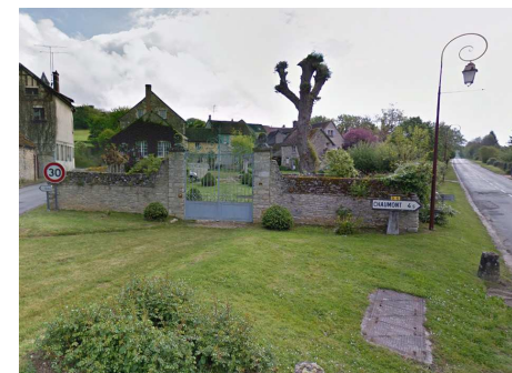
Murs anciens en pierres, rue du Réveillon.
