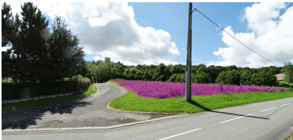
Vue sur l'emprise aménageable avec une desserte à prévoir depuis la voie interne existante.
