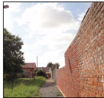
Ruelle de la faux
