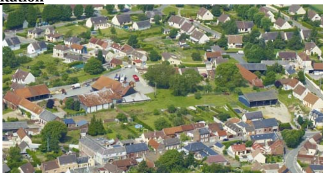
Exploitations agricoles en cœur de bâti à potentiel de requalification
