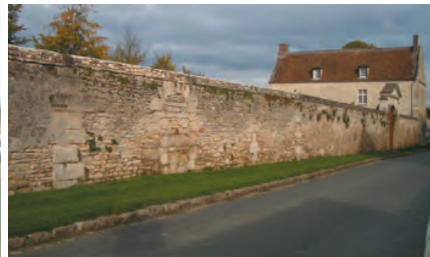
Mur d'enceinte du château, avec chaînages en pierre de taille et traces d'anciennes ouvertures.
