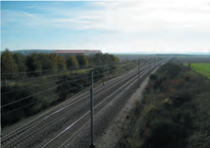
Le passage très fréquent du TGV Nord produit des nuisances sonores importantes au niveau de La Borde.
