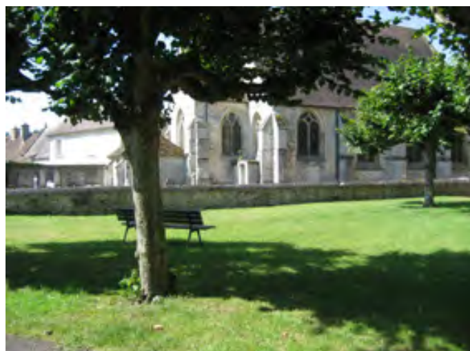
Muret d'enceinte du cimetière communal au centre de Raray.
