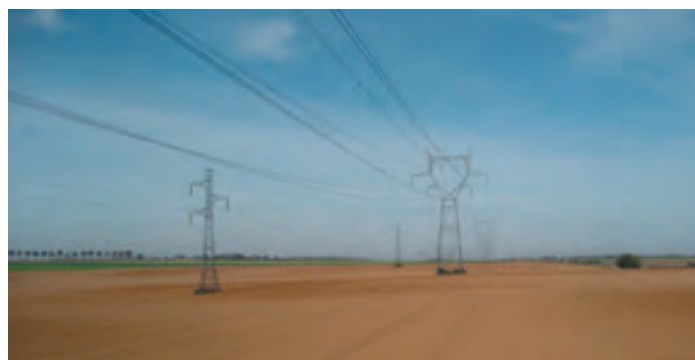
La ligne à haute tension est essentiellement visible par la présence des pylônes et a tendance à se fondre dans le grand paysage.
