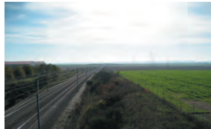
La ligne de TGV Nord doublée de la ligne à haute tension, traverse le territoire communal du nord au sud en déblais ou en remblais.
