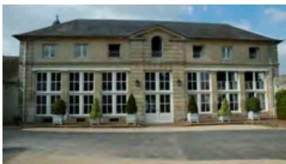
Bâtiment de l'orangerie sur la cour d'honneur, revonverti en hôtel
