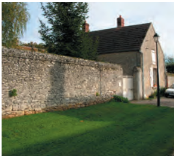
Mur de clôture dans la rue du Manoir.
