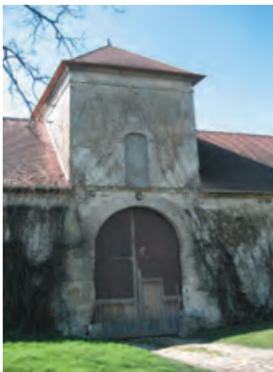
Porche d'entrée dans la ferme.
