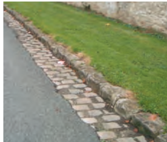
Les caniveaux sont réalisés en pavés en grès aux joints non maçonnés et les trottoirs sont délimités par des bordures également en grès.
