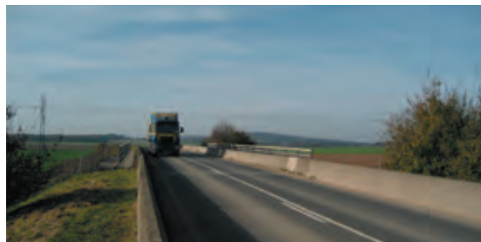
La continuité de la RD 554 est assurée par un pont au dessus de la voie du TGV. C'est la seule route reliant le village à son hameau.
