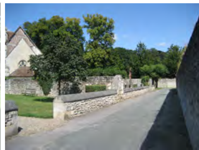
Muret délimitant le square communal. Il s'agit à l'origine d'un mur plus élevé dont la hauteur a été rabattue lors de travaux d'aménagement du square.
