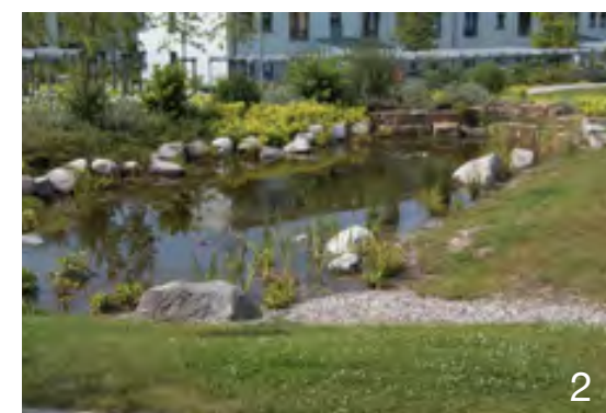
2 Bassin de rétention (ou mare) intégré dans un lotissement.
