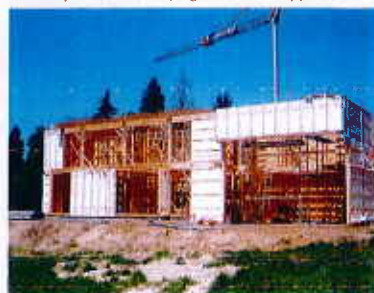
Chantier d'une maison à ossature bois
