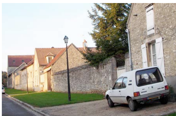
Mur en pierres (rue du Manoir).
