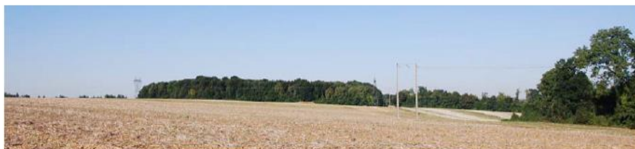
Les lignes électriques
