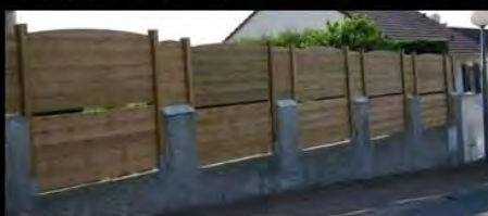
Clôture bois en muret enduit
