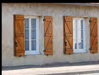
Volets à écharpes
