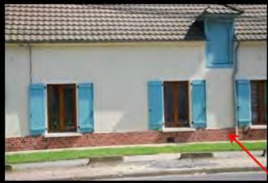
Ancien recouvert d'enduit
