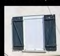
Volets à écharpes
