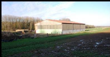
Hangar agricole isolé, situé au nord-ouest de la commune
