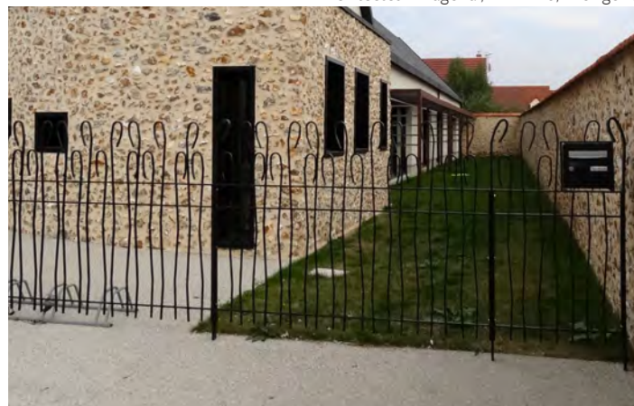
Ferronneries contemporaines formant une clôture
