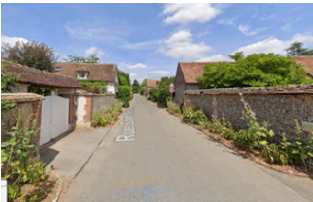
Murs en pierre au nord
