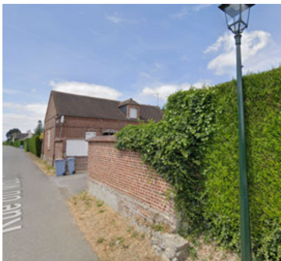
Mur en brique rouge
