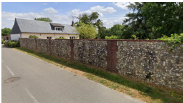
Mur en pierres et briques
