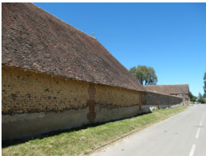
Mur remarquable de la ferme
