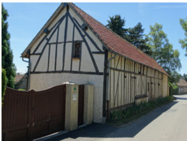
Construction à ossature bois apparente
