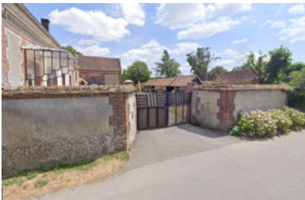
Mur en pierre et brique
