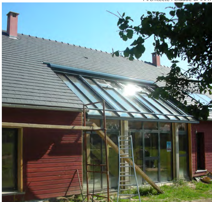
Création d'une verrière dans un volume traditionnel
