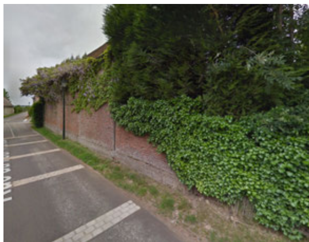
Mur en brique rouge
