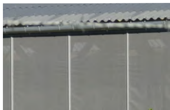
Toile et tôle ondulée
