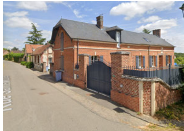
Mur et piliers en brique
