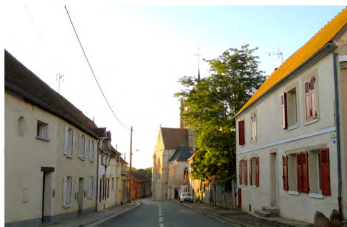
Habitat traditionnel aux façades entretenues, enduites (Fresnes-l'Eguillon)
