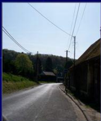
Réseaux aériens, bas côtés inadaptés aux déplacements des piétons, peu de valorisation du centre de village (église, place)
