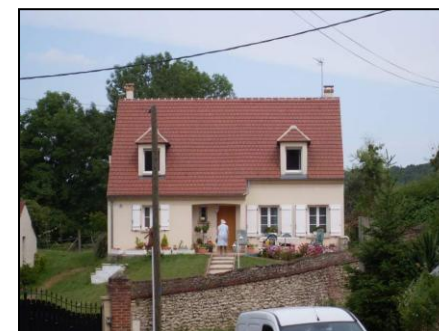
Construction pavillonnaire récente
