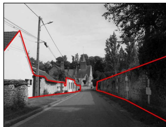
Continuité visuelle interrompue
