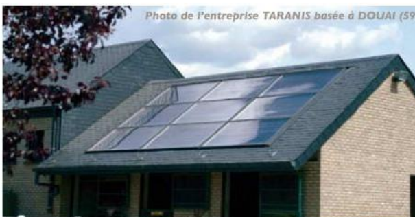
La pose de capteurs sur l'ensemble du versant de la toiture aurait permis une meilleure intégration
