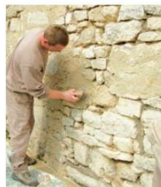
Rénovation à la chaux
