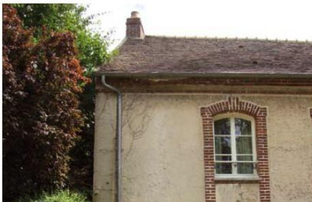
Fenêtre rénovée (bois) double vitrage
