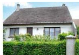
Maison de constructeur
