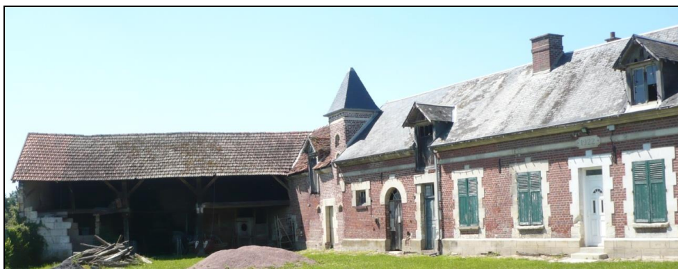
Ancien corps de ferme (n°18)
