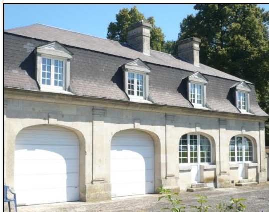
Dépendance à l'entrée du château (n°12)
