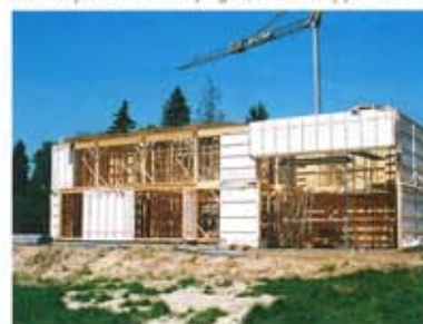
Chantier d'une maison à ossature bois
