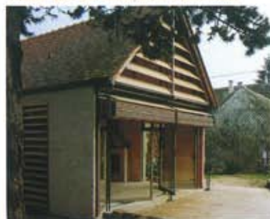
Habitat de composition simple, l'une avec un pignon s'ouvrant ou se fermant par un système de volets, l'autre offrant un auvent servant d'abri voiture
