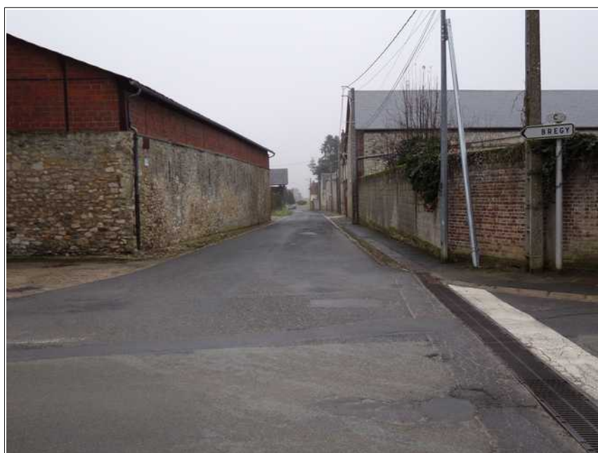
Figure III.6: La route de Bregy peut être empruntée par des écoulements. Elle reçoit également des eaux de pompage des sous-sols.
