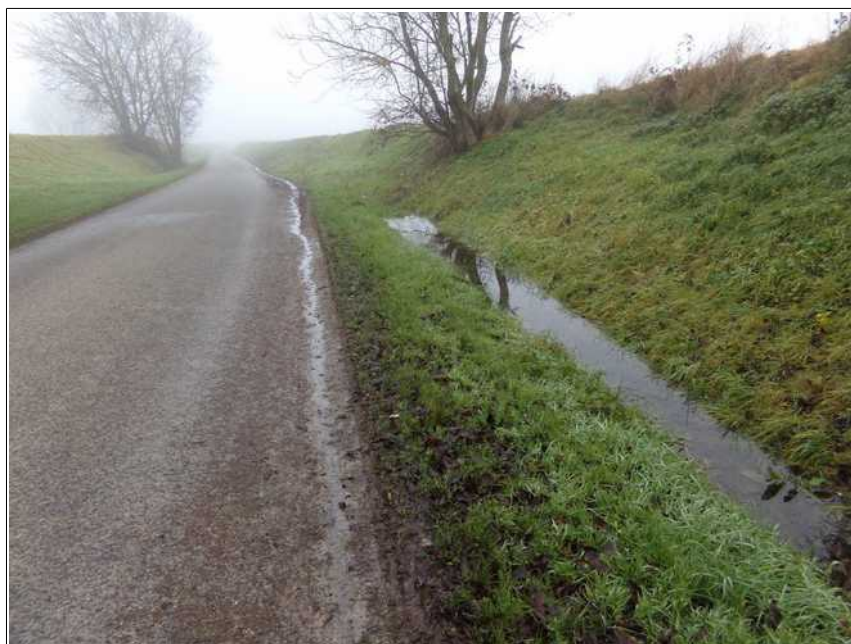
Figure III.5: source du village (émergence de la nappe) drainée par le fossé de la route de Nanteuil-le-Haudouin. La route peut également servir d'axe d'écoulement préférentiel des ruissellements de surface.
