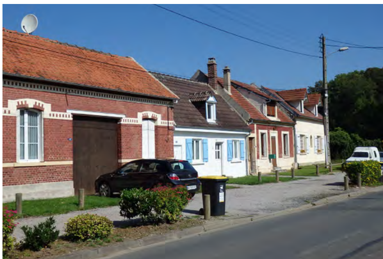
Constructions anciennes en brique et pierre ou enduites, lucarnes jacobines et chien couché.
