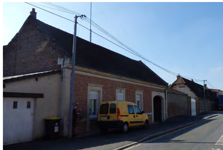
Bâti traditionnel en brique et construction annexe toiture monopente à l'alignement.
