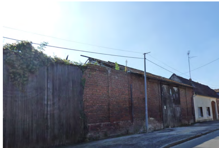
Anciens bâtiments de corps de ferme en brique à l'alignement de la voie (03/09/2014)
