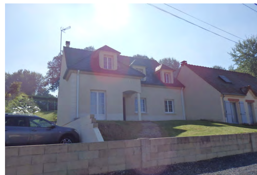
Constructions récentes rue du Capitaine Maillard en retrait de rue et haut de talus.
