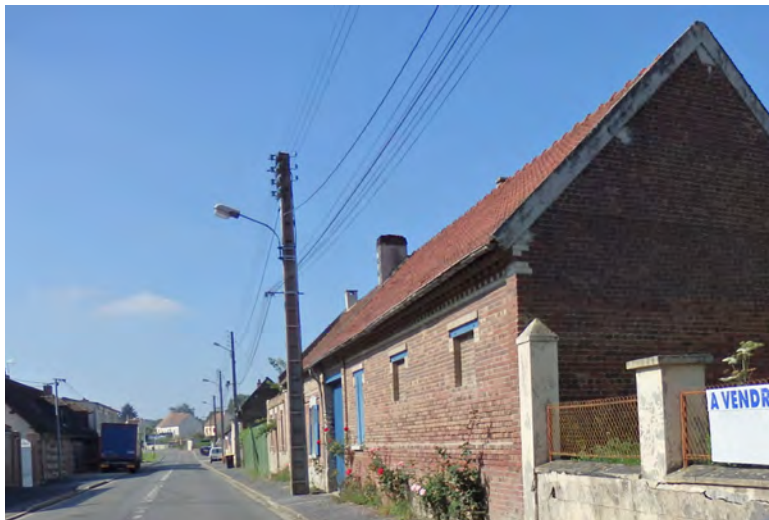
Ancien bâtiment annexe en brique, à l'alignement, réaffecté à l'habitation
