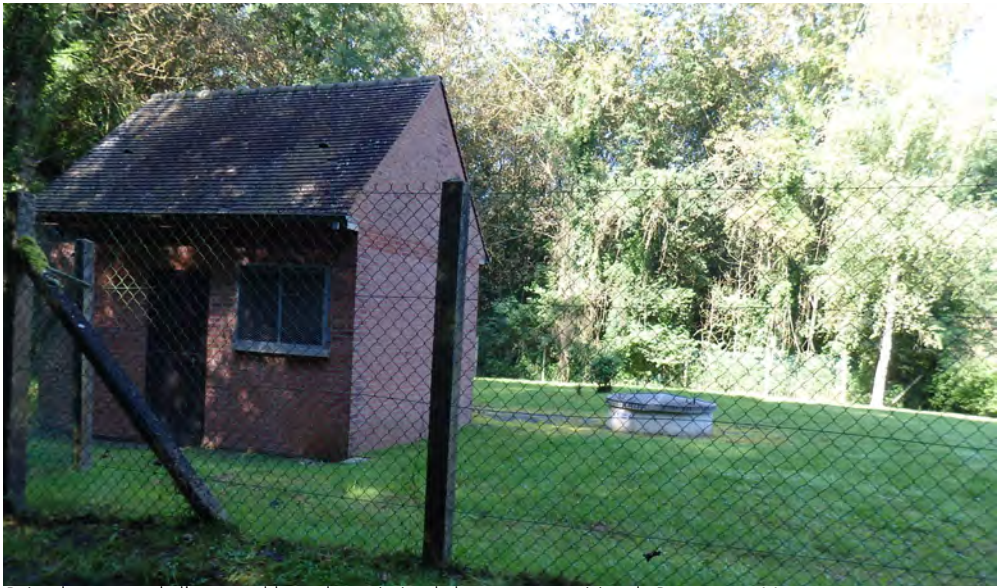
Point de captage de l'eau potable sur le territoire de la commune voisine de Ressons sur Matz.
