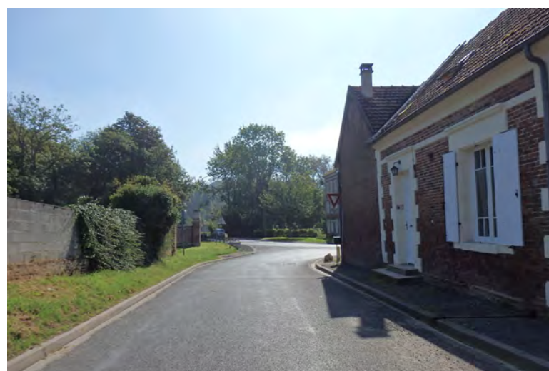
Construction traditionnelle ancienne à l'alignement de la voie en brique et pierre.
