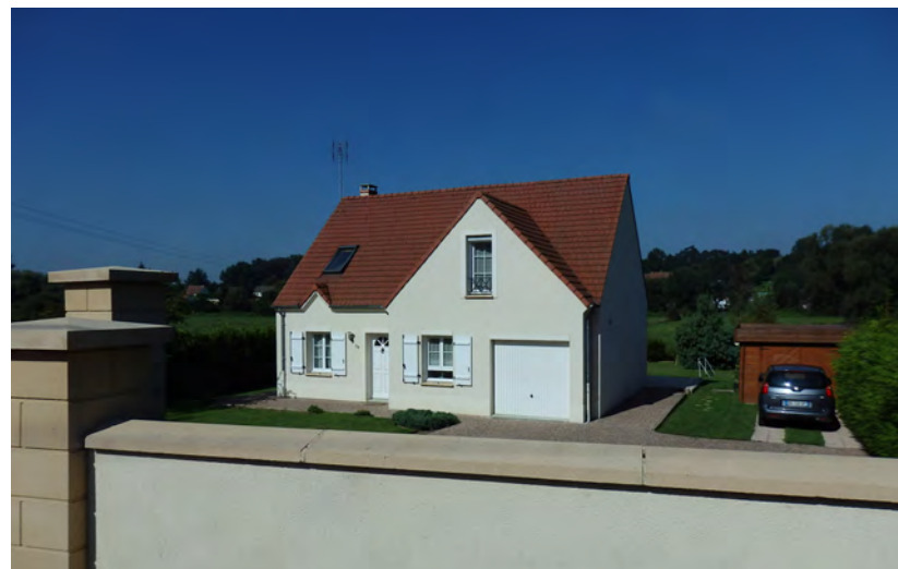
Construction neuve en retrait de rue du Capitaine Maillard au sein de «la «Plaine»»
