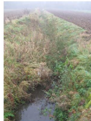
Photo 119, Vue en aval de La Fontaine Caboche, depuis la RD 99 curée immédiatement après les inondations.
