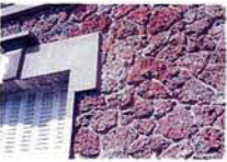
meulière avec joint creux au mortier bâtard
