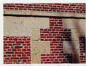
mur de brique avec bandeau et encadrements en pierre de taille
