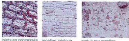
joints en concassés moellon jointoyé enduit sur moellon
