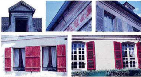
modénatures en pierre de taille : bandeau, corniche
