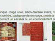
brique rouge usée, silico-calcaire claire, vernissée et cernée, badigeonnée en rouge, posée à chevron, formant un escalier ou un couronnement de clôture
