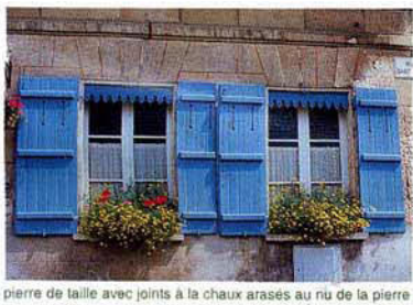
Pierre de taille avec joints à la chaux arasés au nu de la pierre
