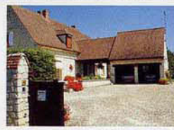
percements et occultations de baies, extensions d'annexes contemporaines intégrées aux volumétries existantes
