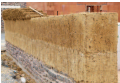
Mur en bauge en cours de construction
