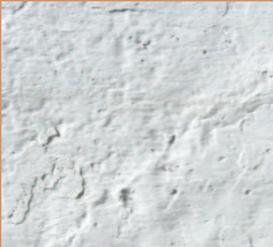
Badigeon au lait de chaux
