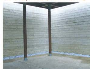
Préau aux Clayes-sous-Bois, archi. Anne Delaunay
