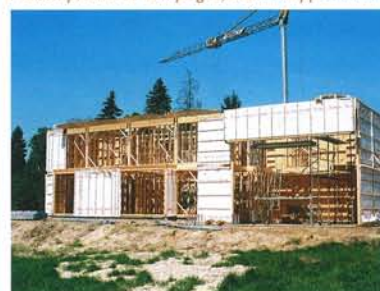
Chantier d'une maison à ossature bois
