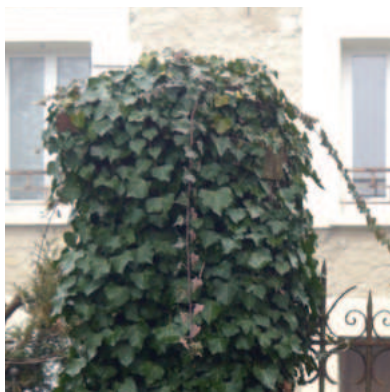
Dévégétaliser les piles et murets
