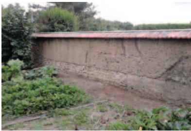
Mur de clôture en pisé
