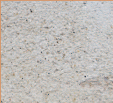
Enduit couvrant à texture grossière
