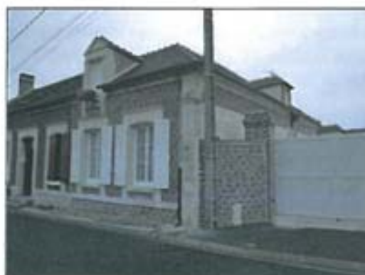
Fenêtre à 2 vantaux, linteau et cadre en pierre, 3 carreaux par ouvrant ; volet persiennés en partie haute.
