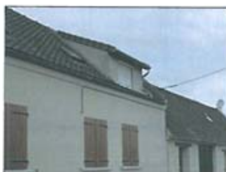
Tuiles mécaniques et tuiles plates. Lucarne rampante.
