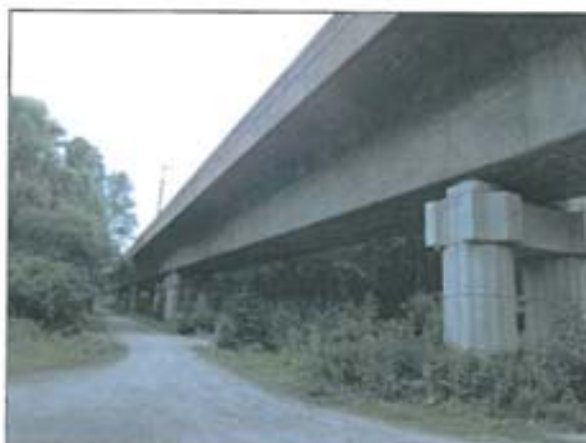
Pont de l'A1 depuis le CR d'Eparmont au moulin de Lagny
