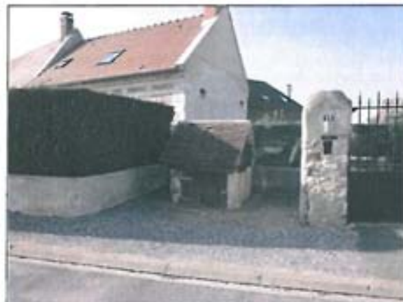
Le puits rue neuve
