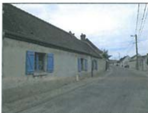
Fenêtres à 2 vantaux, 1 carreau par ouvrant ; volets pleins en écharpes.
