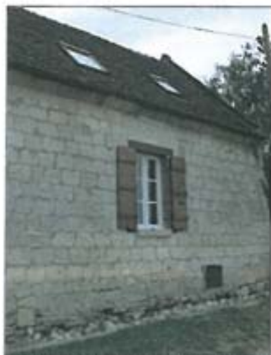
Fenêtre à 2 vantaux, division en 3 et linteau en bois ; Carreau par ouvrant ; Volets pleins avec 3 barres transversales
