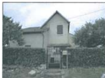
Ancienne construction en pierre, agrandissement/rénovation avec utilisation d'enduit
