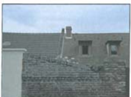
Tuiles mécaniques, lucarne à la capucine
