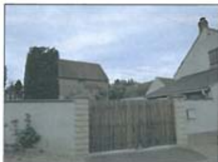
Premier plan : construction enduite avec soubassement en brique ; Arrière-plan : bâtiment en brique
