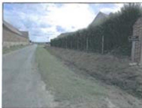
Fossé dans le chemin de Beaumanoir
