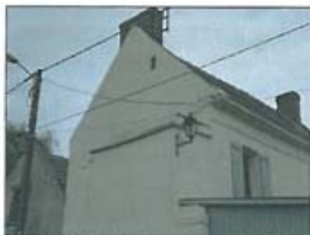
Construction enduite anciennement en pierre et brique : Pignon à redents, trace d'une modénature en brique au-dessus du linteau certainement en pierre
