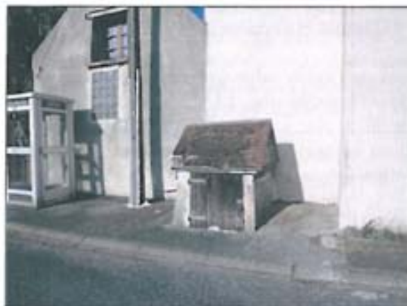
Le puits rue de la mairie
