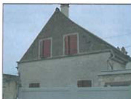
Pignon à redents, corniche en pierre
