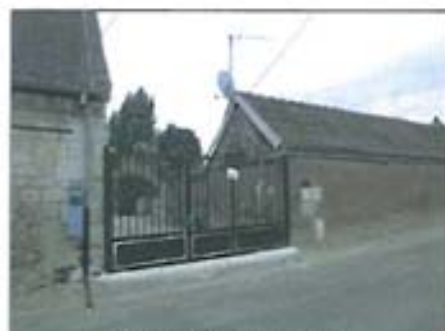
Construction en brique, bardage bois sur pignon
