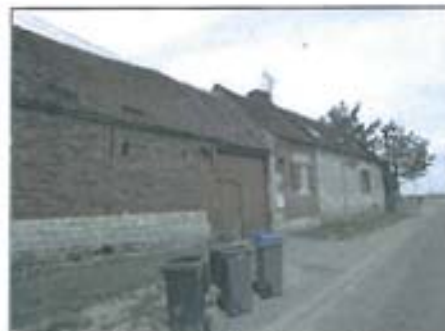
Façade composite : pierre et brique
