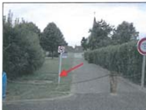
Puits d'infiltration au point bas de la rue de la Mairie
