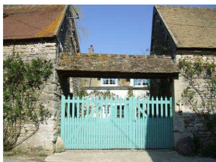
Annexes à l'alignement de la voie
