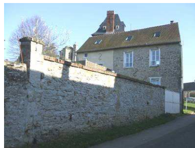
Mur de clôture en moellons apparents
