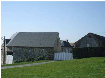
Ancienne ferme réhabilitée
