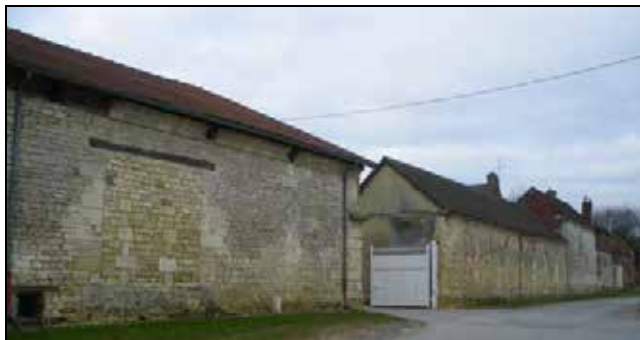
Exploitation agricole rue de l'église
