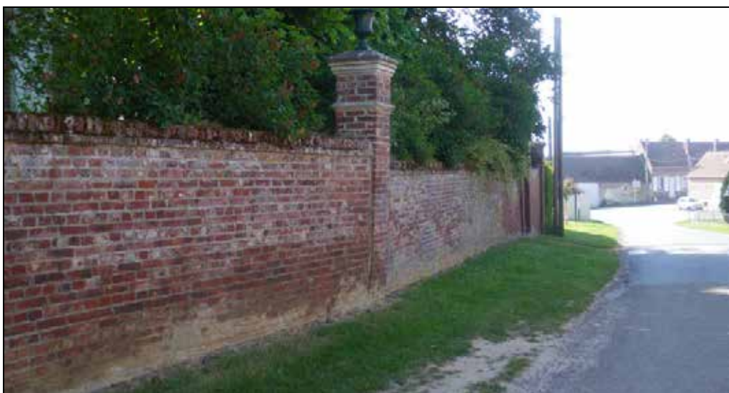
Photographies illustratives des murs protégés (Rue de Coivrel/Place de la Mairie)
