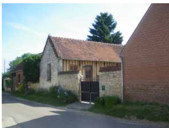
Rue de Coivrel Structure de pans bois remplie de torchis Pignon en pierre et en brique « couteau picard »
