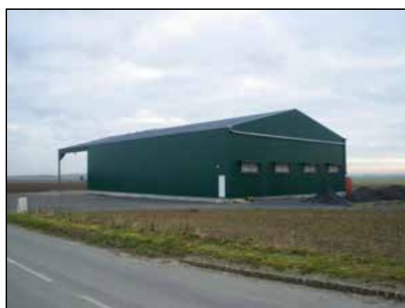
Vue depuis la Chaussée Brunehaut – RD 27
