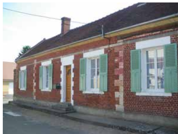
Rue de Coivrel Construction en briques Encadrements de porte et harpes en pierre Bandeau en pierre / Escalier d'accès simple
