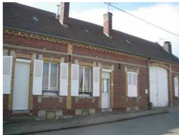
Chaussée Brunehaut Construction en briques Corniche et bandeau en pierre / Grand porche cintré Eléments de ferronnerie aux fenêtres
