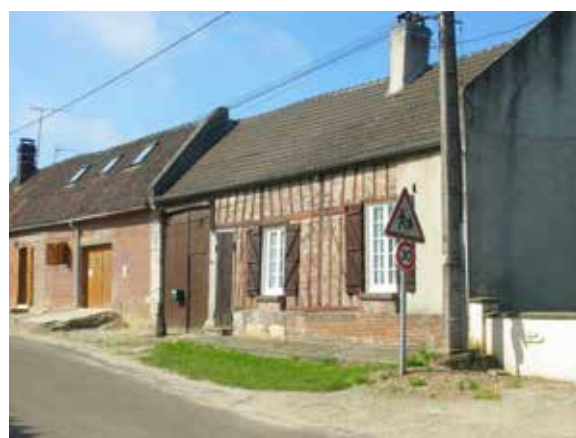
Rue de Coivrel Mur composite : structure en bois avec remplissage de briques / Soubassement en briques Grand porche d'entrée
