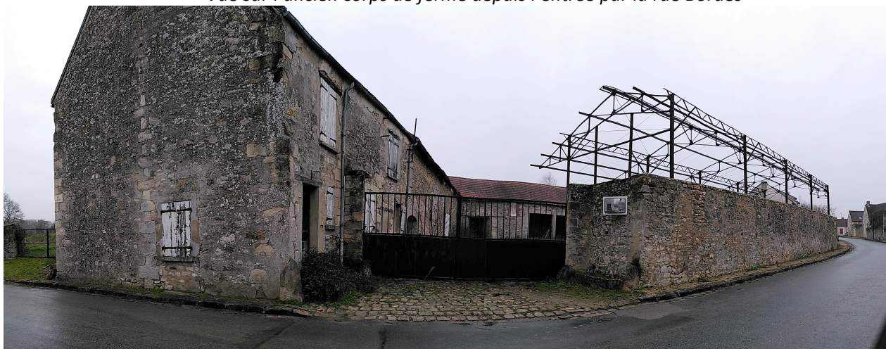
Vue sur l'ancien corps de ferme depuis l'entrée par la rue Bordes
