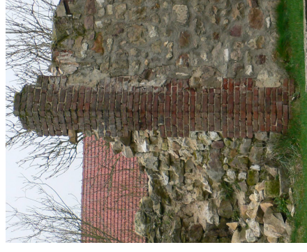
Chainage d'angle en brique subsistant sur un mur très dégradé.
