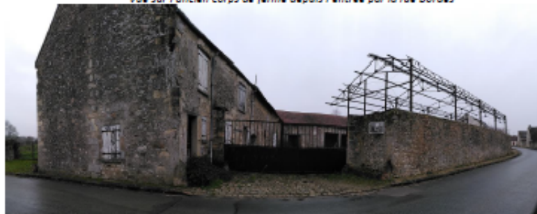
Vue sur l'ancien corps de ferme depuis l'entrée par la rue Bordes
