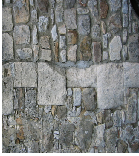
Mur composite (grès et calcaire) avec chaînage en pierre calcaire taillée
