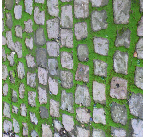
Pavés en grès avec des joints remplis de sable ou végétalisés.
