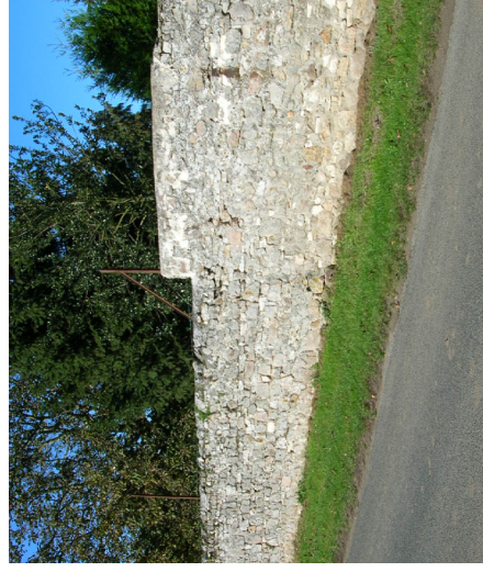
Mur de clôture construit majoritairement en moellons de calcaire. Son aspect général est plus "froid" qu'un mur en grès et nuancé de gris.
