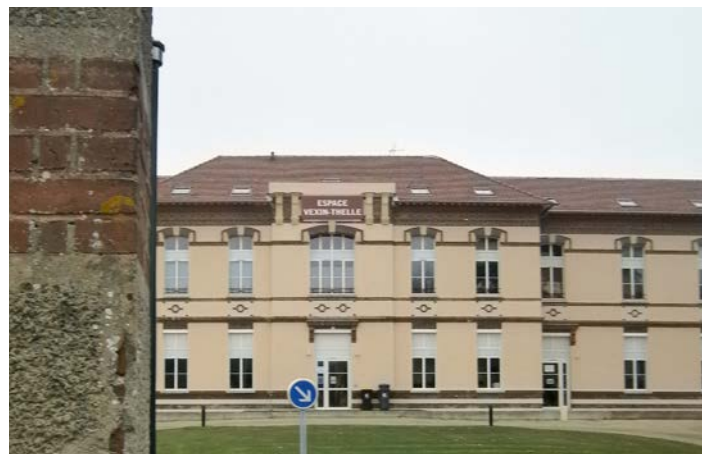
Reconversion d'un équipement public
