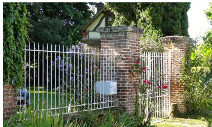
Une clôture composée de murs bahut surmontés de fines ferronneries, de piles en briques et d'un portail ajouré
