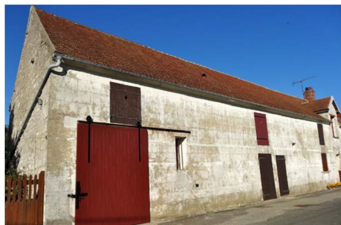
Portes coulissantes pour un usage pratique (Liancourt-St-Pierre)
