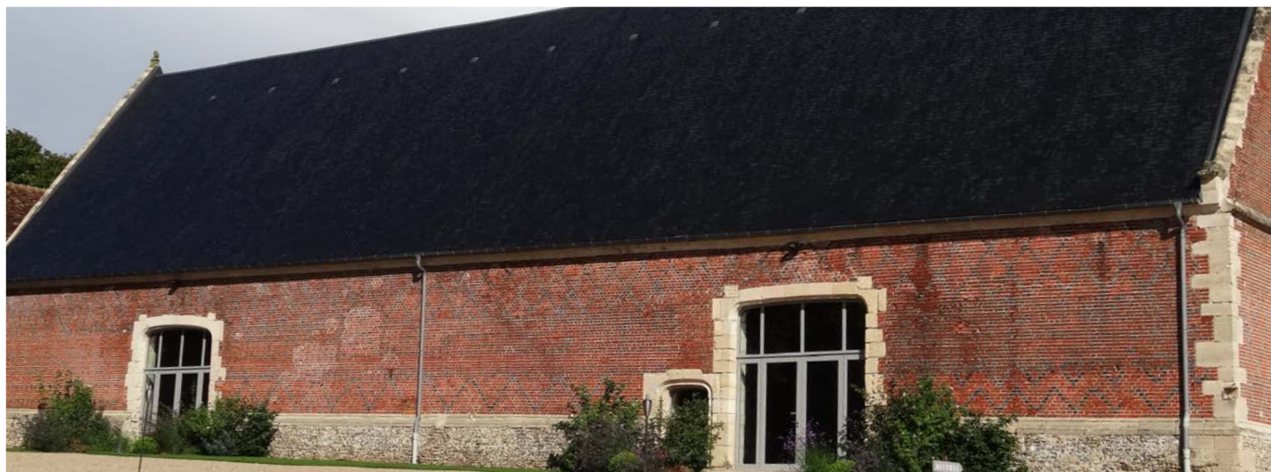
Grange convertie en locaux de séminaire (Boissy-le-Bois)
