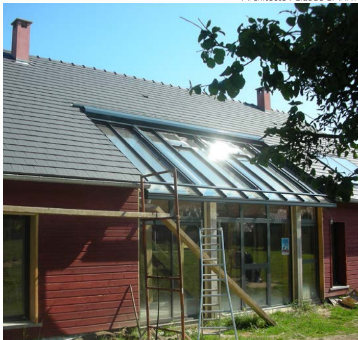
Création d'une verrière dans un volume traditionnel
