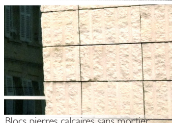
Blocs pierres calcaires sans mortier
