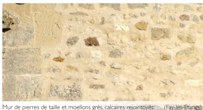
Mur de pierres de taille et moellons grès, calcaires rejointoyés (Fay-les-Etangs)
