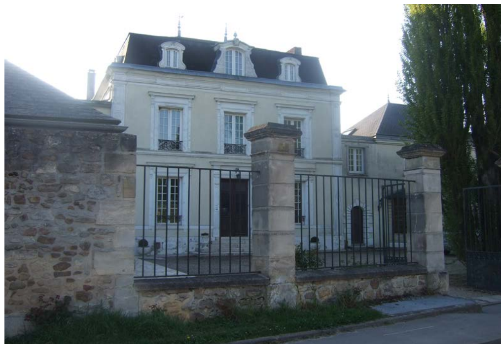
La maison de retraite située sur la rue d'Auneuil.
