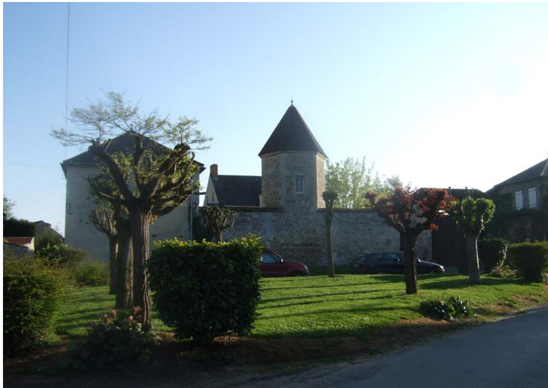
Le petit manoir situé dans la trame urbaine ancienne de Monneville
