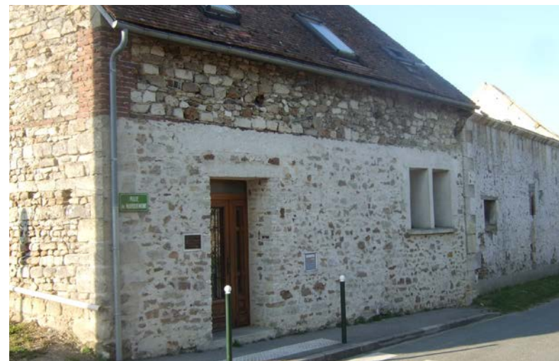
Construction traditionnelle avec façade en briques et moellons.
