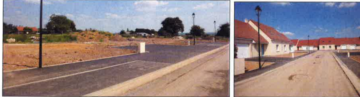
Photographie des liaisons viaires de la zone HLM en cours de construction
