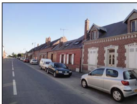
Rue de Ressons
