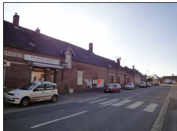
Rue de Ressons
