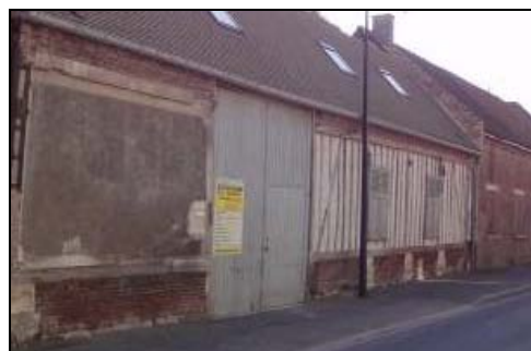
Rue de Tricot Construction présentant encore le sous bassement en brique, une poutre en bois puis les pans bois sur la façade
