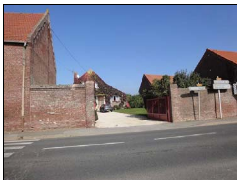
Rue de Tricot Maison d'habitation en retrait A l'alignement : bâtiment et mur de clôture en briques
