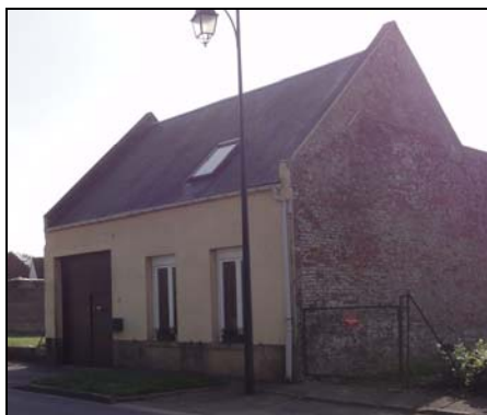
Construction rue de Tricot sans volets
