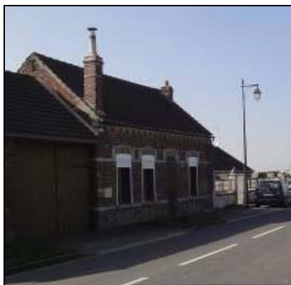
Rue de Tricot Construction à l'alignement
