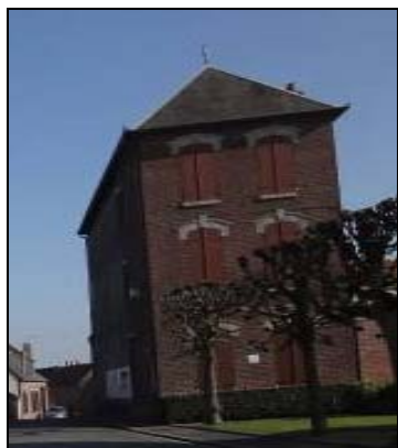
Construction à l'alignement rue du bois R+2+C
