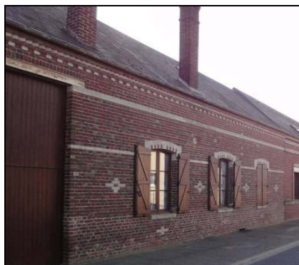
Construction en briques dans la rue de Ressons Ouverture en 2 vantaux avec division en 3 carreaux
