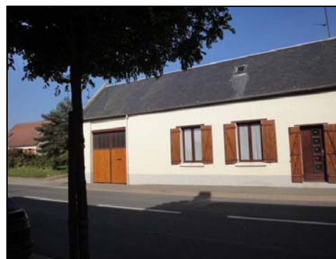
Rue de Tricot Rénovation de fenêtre en 1 seul carreau par ouvrant
