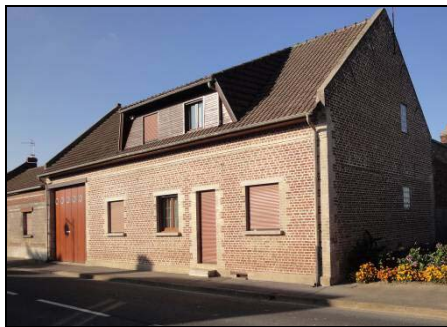
Rue de Resson Fenêtres plus larges que hautes
