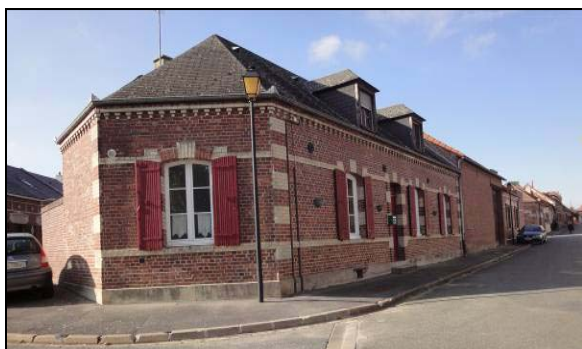
Rue du 114 ème de ligne Couleur briques, pierre, blanc et ton bordeaux
