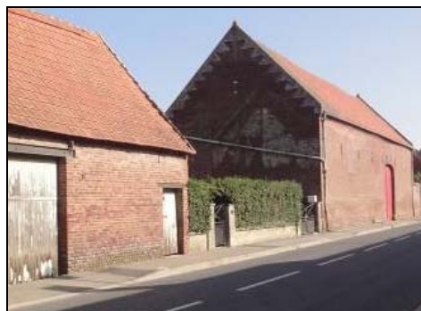
Rue de Tricot Pignon dit « couteau picard » avec épi de faîtage en pierre Porte charretière sur la façade
