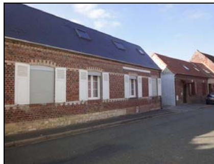
Rue du bois Mise en place de volet roulant qui masque les carreaux de la fenêtre avec maintien de volets
