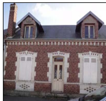
Rue de Ressons Caractéristique de la porte avec imposte vitrée Volet persienné partie haute
