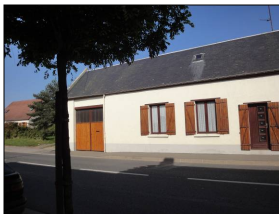
Rue de Tricot Couleur enduit ton pierre, ardoise et ton bois
