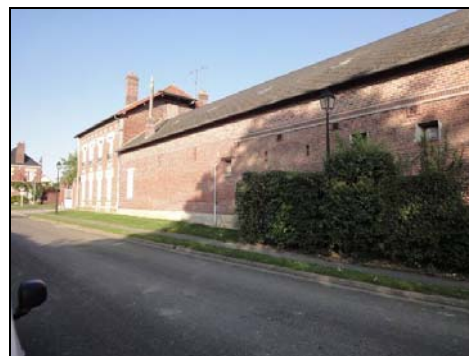
Maison « bourgeoise » à l'alignement rue de Moyenneville Bâtiment à l'alignement le long de la rue de Moyenneville
