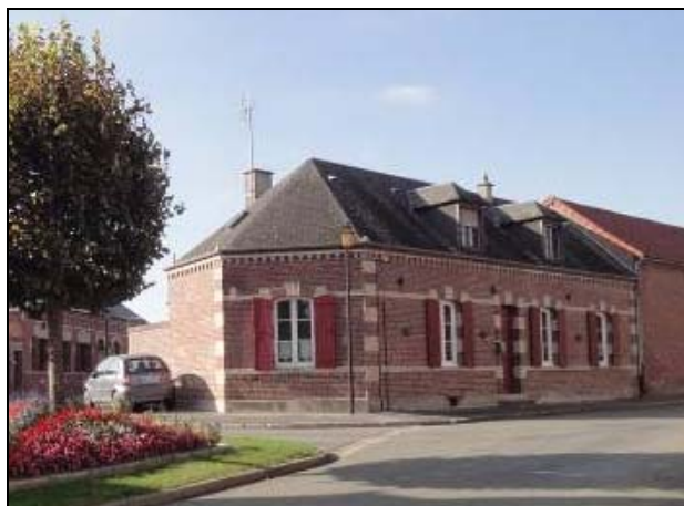
Vue de la place du général Mangin Construction d'angle avec toitures à plusieurs pans Lucarne à capucine
