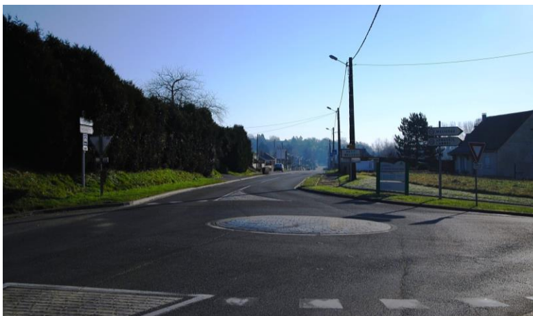
Figure 50 : Entrée ouest du Petit Mélicocq
