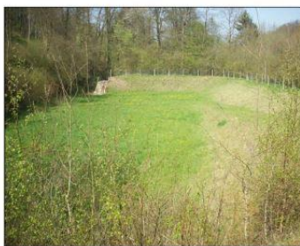
Bassin pluvial existant – Chemin des Préaux
