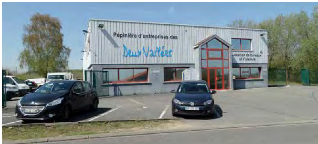
Bâtiment d'activité rue Bernard Bordier (ZA de Longueil-Annel)
