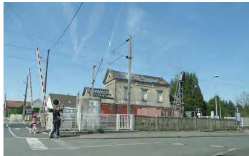
Passage à niveau entre la voie ferrée et la rue de la gare (à sens unique)/ rue de Poste
