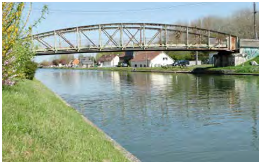
Unique pont automobile permettant de traverser la canal latéral sur la commune
