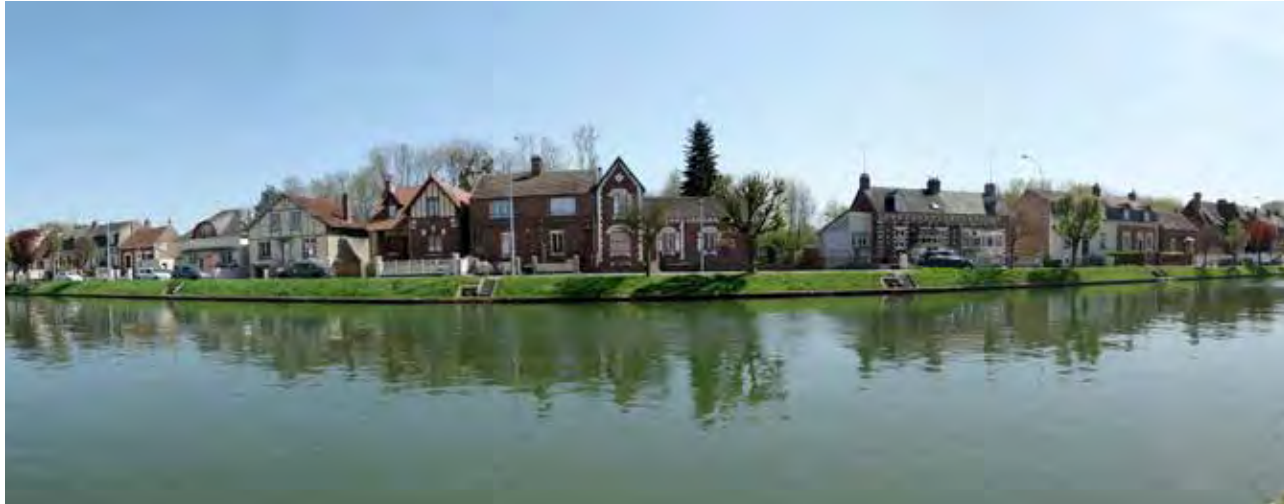
Maison des bateliers (côté nord du Canal, avenue du Général de Gaulle)
