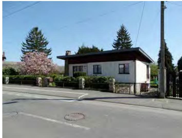
Logements réalisés dans les années 1960 rue de la Mairie
