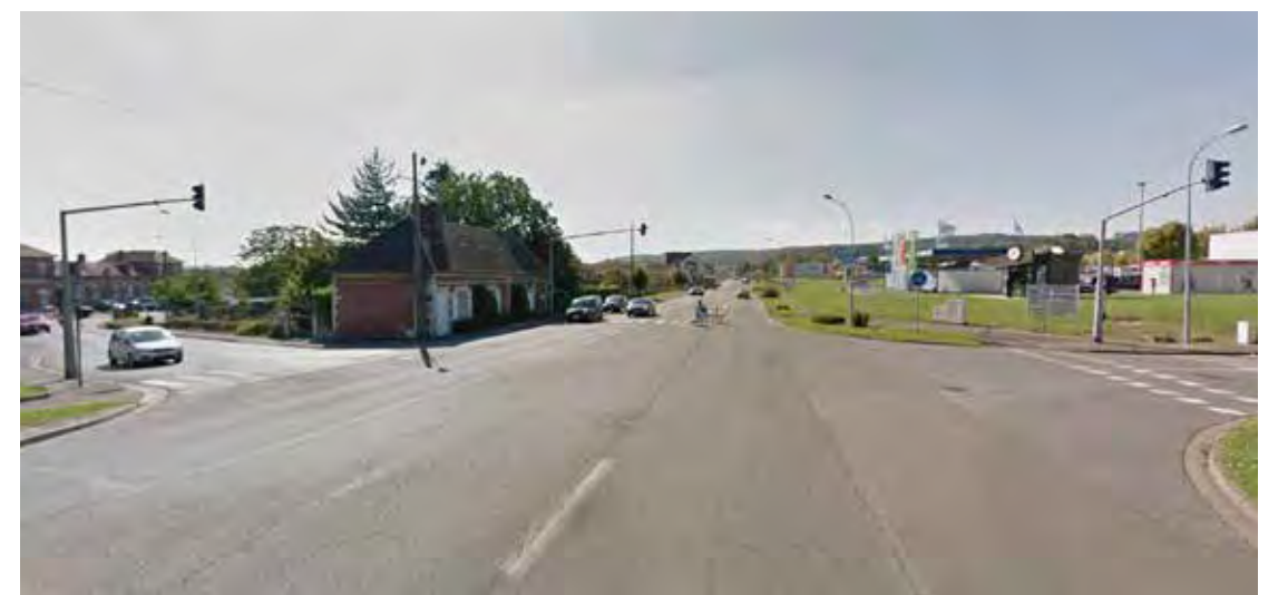
Carrefour entre la rue traversant la zone d'activités, l'avenue de la Libération (RD932) et la rue de la Mairie
