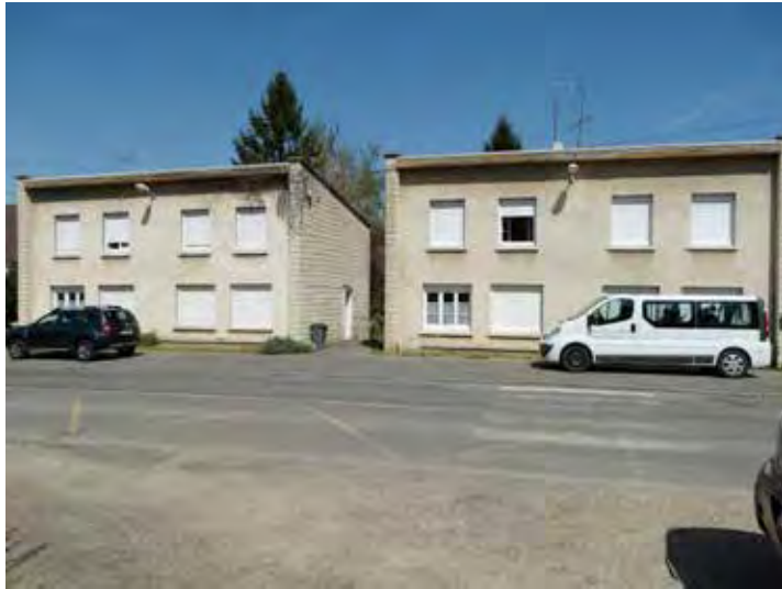
Logements réalisés dans les années 1950 à Annel
