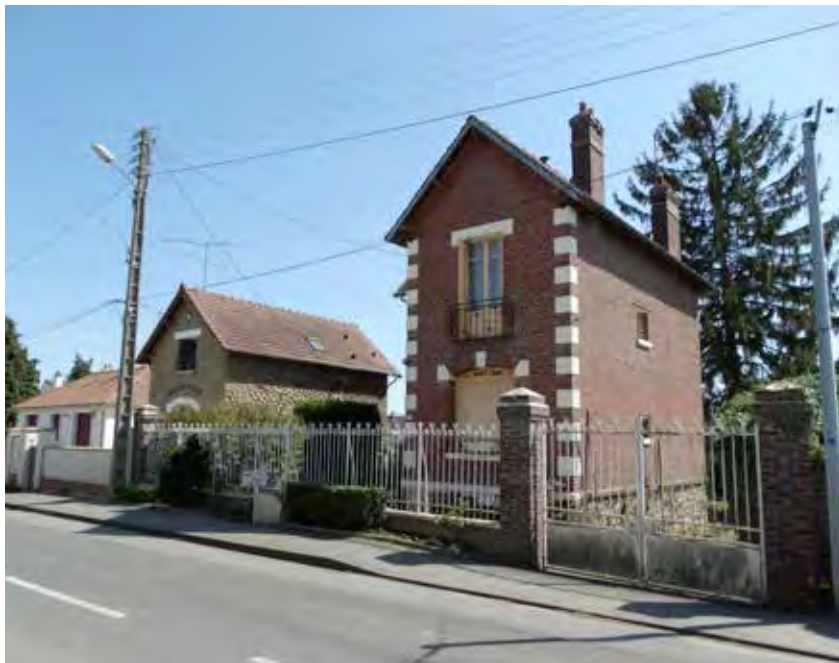
Maison bourgeoise en briques à Longueil (rue de la mairie)
