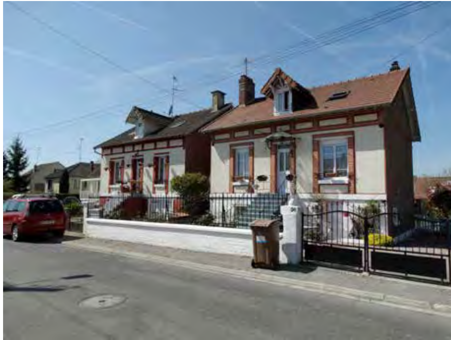
Maisons rurales en briques (enduites) et modénatures en briques rouges apparentes (rue de la Mairie)
