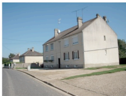
Bâtiment collectif en retrait de la rue de Liancourt Saint Pierre.
