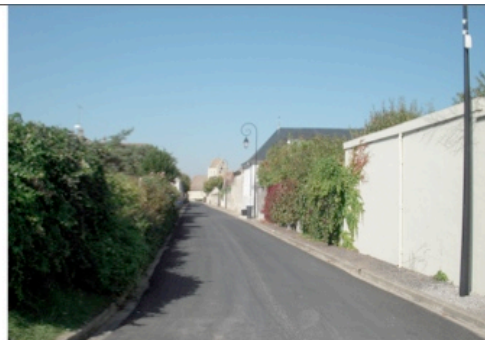
Absence ou trottoirs étroits le long de la rue de l'Église.
