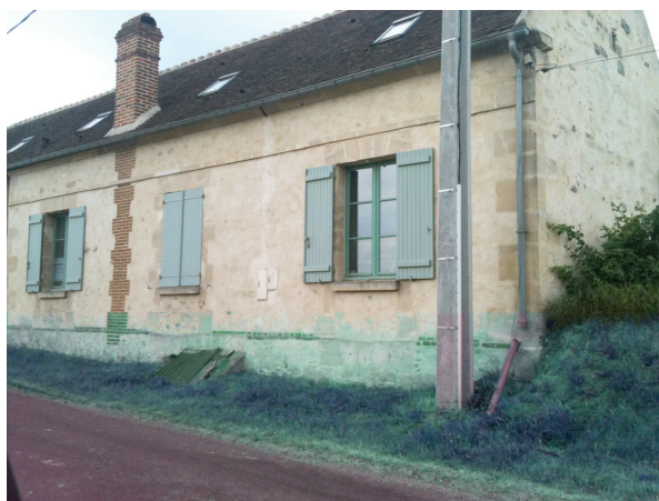
Façade en pierre, volets à deux battants.
