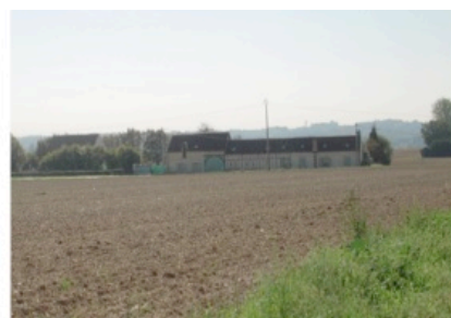
Construction en pans de bois en entrée de village est, le long de la RD923.
