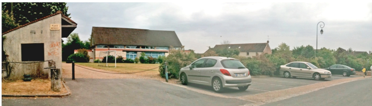
Arrêt de bus et place publique recevant du stationnement le long de la rue de la Mairie et la salle multifonctions dans l'épaisseur de l'îlot.
