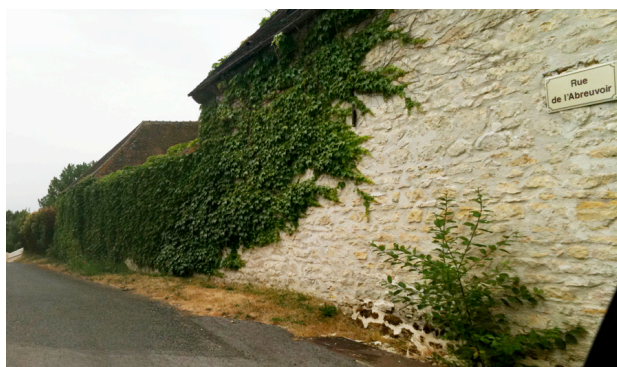
Mur ancien en pierres type moellons.
