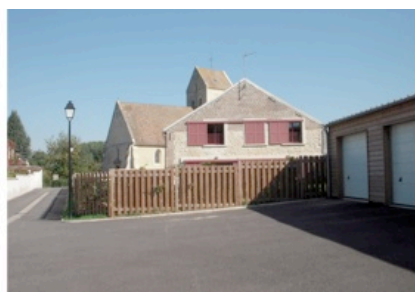
Utilisation de la pierre, de la brique et du bois pour une réhabilitation de bâti ancien face à l'église.
