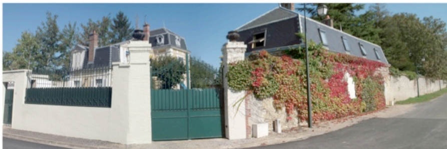
Maison de maître R+1+comble couverture ardoise et toiture à la Mansart. A droite, mur de pierres remarquable donnant sur la plaine.
