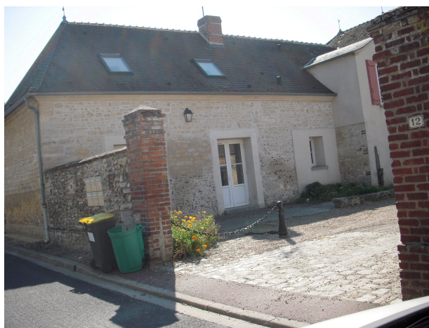
Façade restaurée en moellons et enduits ton pierre.
