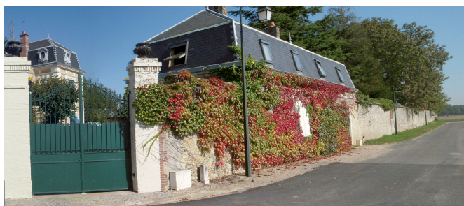
Mur ancien en pierre type moellons (rue Neuve).
