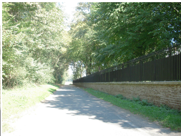
Muret en briques rouges surmonté d'une grille en ferronnerie fine.
