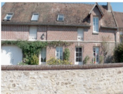
Construction en brique en retrait de rue avec muret de pierre assurant l'alignement sur la voie.
