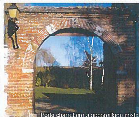
Porte charretière à appareillage mixte.
