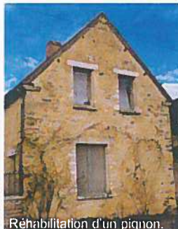
Réhabilitation d'un pignon.
