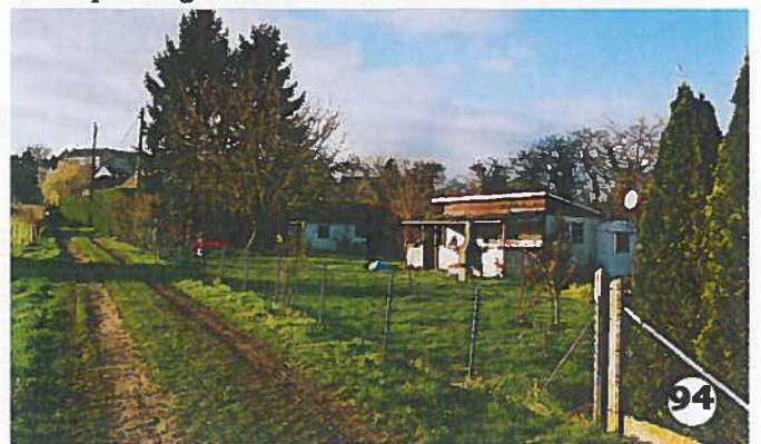
4: Construction "légère" en périphérie du village
