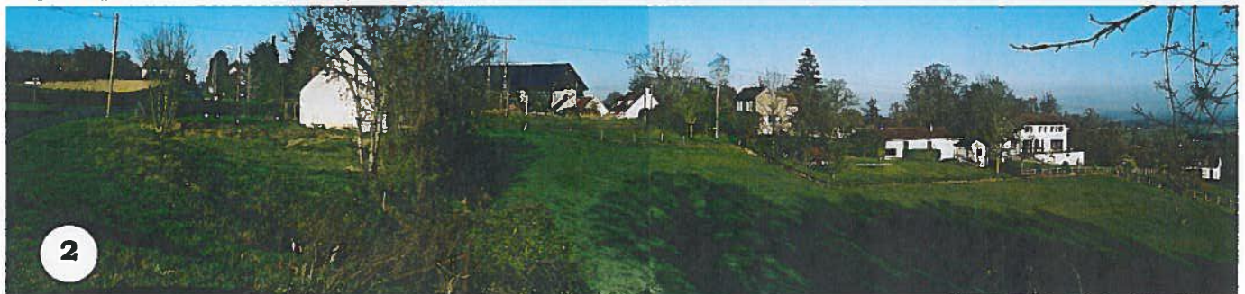
2 Vu de la route des Groux le haut du vallon du Conflan en amont du captage
