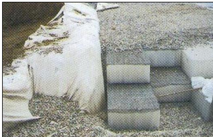
Figure 39. Exemple de stockage en structure alvéolaire
