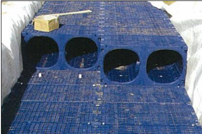
Figure 40. Exemple de stockage par des caissons visitables
