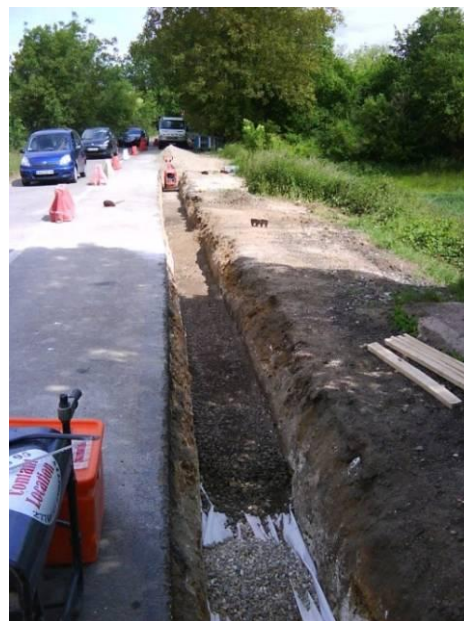
Figure 37. Photographie représentant une tranchée de pose de canalisation
