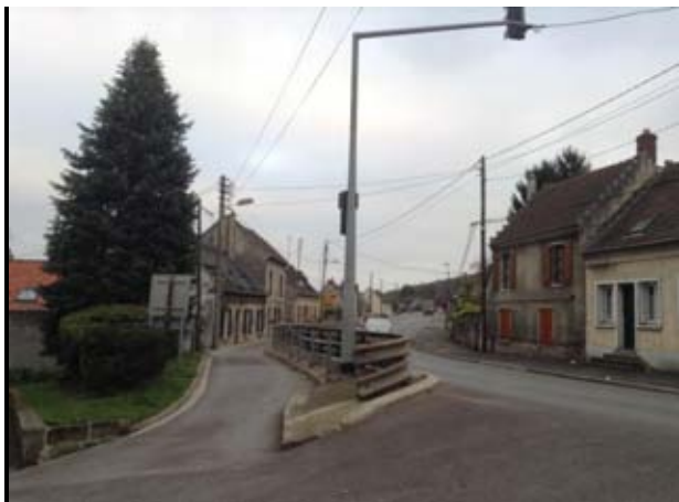
RN 31 au niveau du centre-bourg
