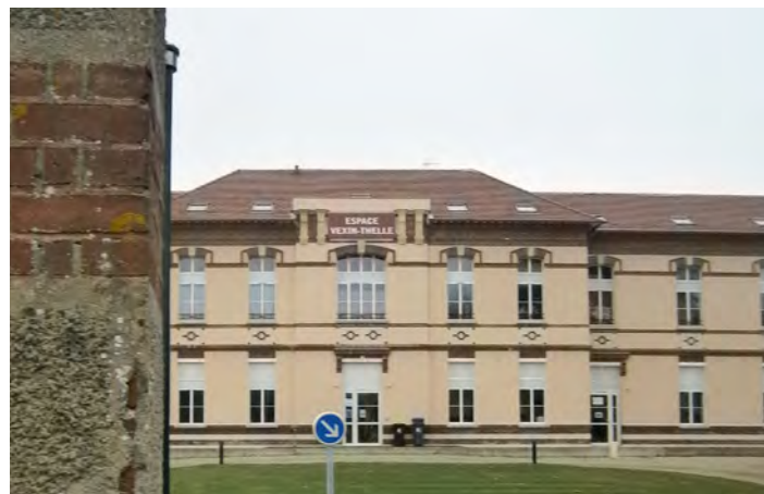
Reconversion d'un équipement public
