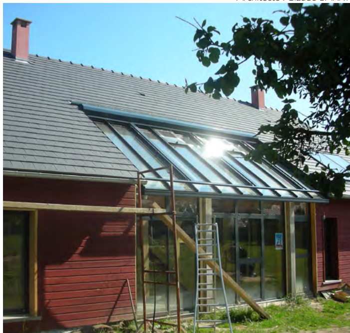
Création d'une verrière dans un volume traditionnel
