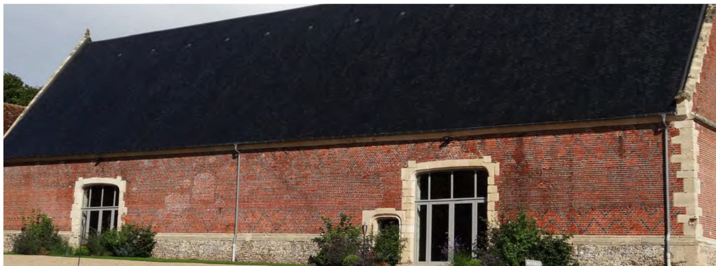
Grange convertie en locaux de séminaire (Boissy-le-Bois)
