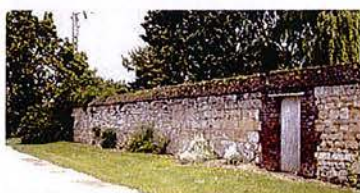
Mur de pierre en blocage avec chaînes et couronnement en brique avec bande herbeuse
