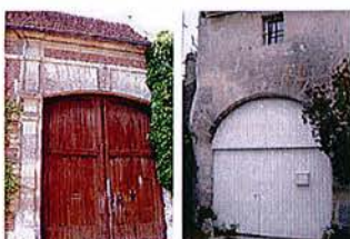
Porche d'entrée avec encadrement ouvragé en pierre
