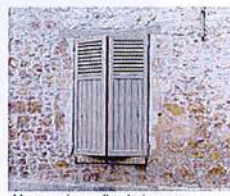
Maçonnerie moellon à pierre vue
