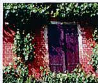
Brique recouverte d'un lait de chaux
