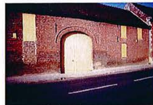
Grange avec porte charretière
