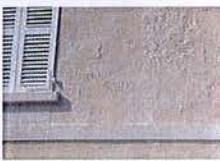
Ravalement d'enduit sur moellon
