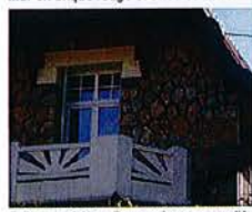
Balcon en béton d'une maison en meulière
