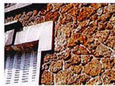
Meulière avec joint creux au mortier bâtard
