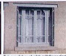
Baie avec linteau et volets métalliques plantés
