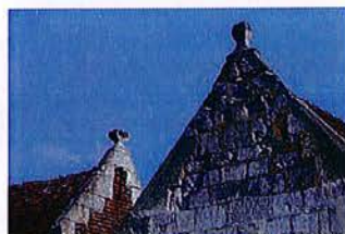
Pointes de pignon avec fleurs du maçon
