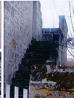
Escalier en pierre sur pignon
