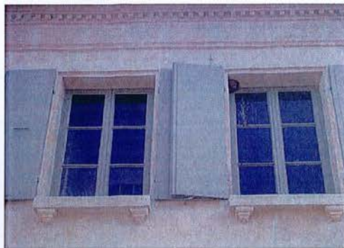
Comiche avec denticules, appuis de fenêtre et feuillure en pierre de taille avec joints à la chaux arasés au nu de la pierre
