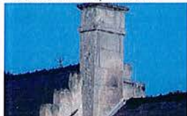
Souche de cheminée en pierre de taille
