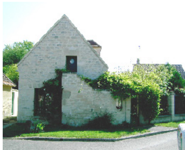
Maison de village à pignon, en moellons, avec murette et jardin en coeur d'îlot.
