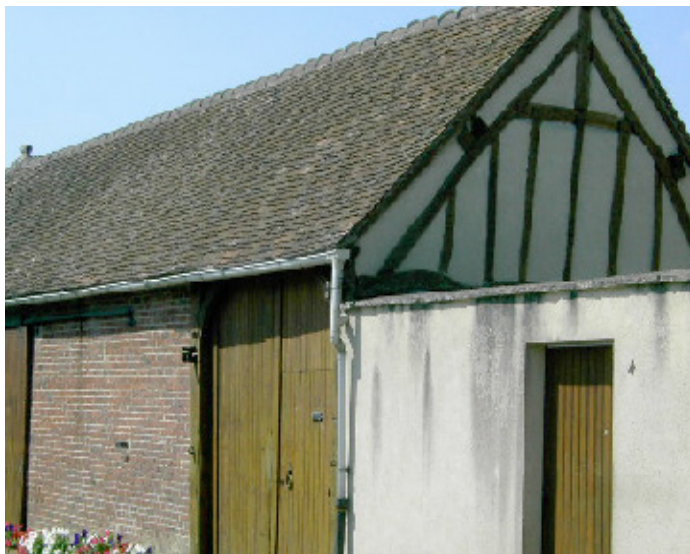
Ancien bâtiment avec charpente en poutres apparente et maison de village en pierre de taille, avec mur traditionnel.
