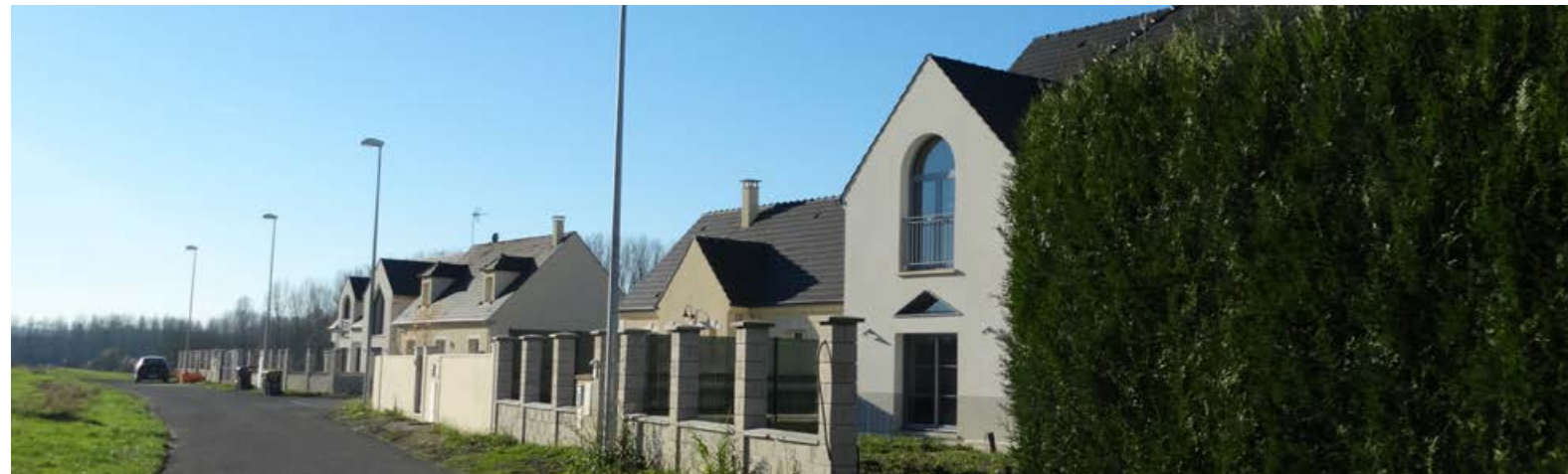
Lotissement du Clos du Vivier, en marge de l'espace bâti. Toitures à pignon et constructions en R + 1.
