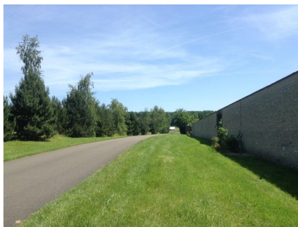
Haie séparant la RD 12 et l'entrée de ville nord
