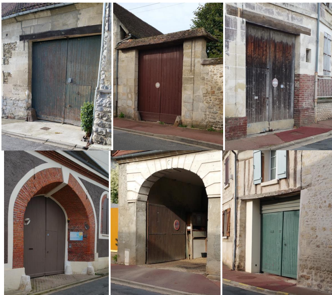
Figure 64 : Exemples de portes charretières protégées
