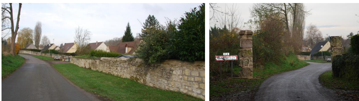
Figure 71 : Mur et colonnes en pierre protégés
