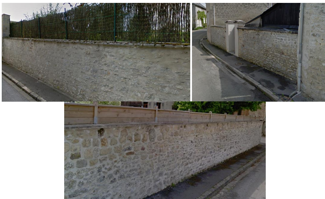
Figure 65 : Exemples de murs protégés
