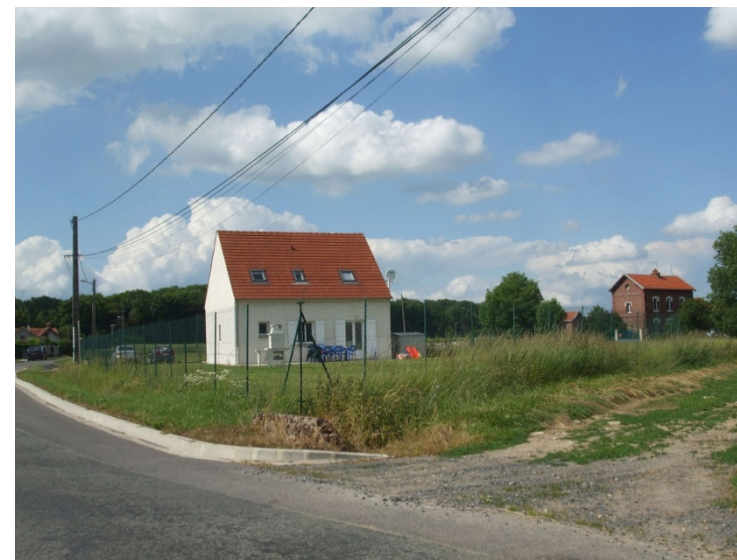
Exposition visuelle importante d'une nouvelle construction
