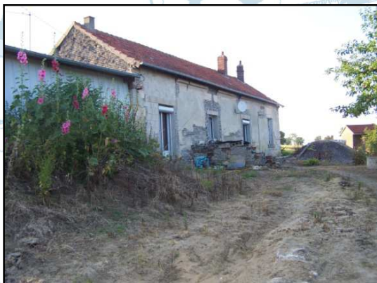
Maison en cours de rénovation à GURY
