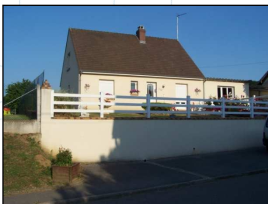
Clôture avec mur bahut et grilles
