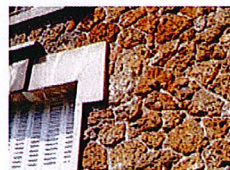
Meulière avec joint creux au mortier bâtard
