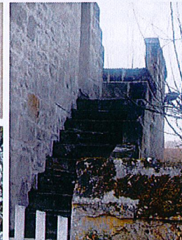
Escalier en pierre sur pignon
