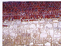
Brique et moellon calcaire
