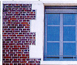
Ravalement de mur de brique, joints à la chaux avec un appareillage paneresses/boulisses, occultation par un store intégré
