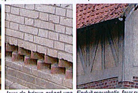
Jeux de brique créant une aération
