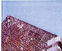
Pignon avec brique en chevron
