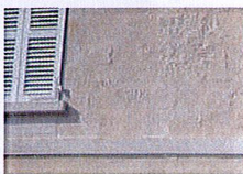
Ravalement d'enduit sur moellon
