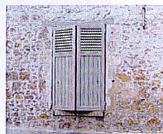
Maçonnerie moellon à pierre vue
