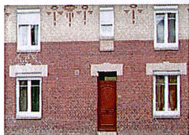
Mur en brique rouge et silico-calcaire
