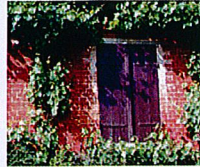
Brique recouverte d'un lait de chaux
