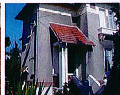
Entrée avec auvent en tuile mécanique
