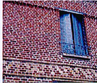
Brique rouge, brique silico-calcaire blanche
