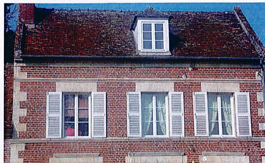
Maçonnerie mixte, volets peints persiennés
