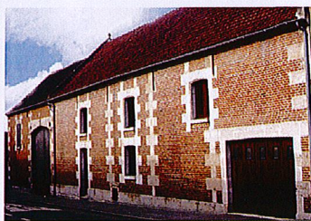
Réutilisation d'une grange en logement
