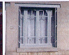
Baie avec linteau et volets métalliques pliants
