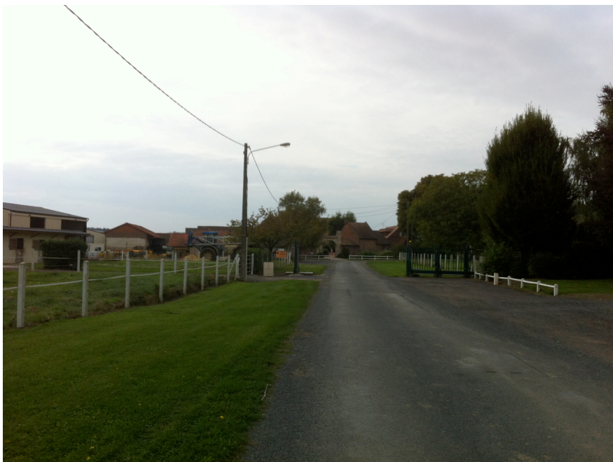
Le site est desservi par une voie privée clôturée
