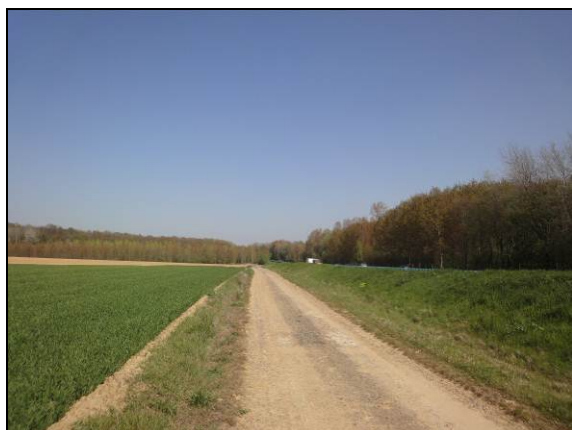
VC n°6 dite voirie de noyon
