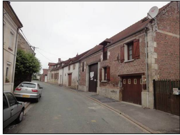
Ouverture d'une porte de garage en façade Pas de cohérence dans l'ordonnancement de la façade
