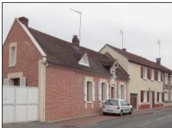
Toiture en ardoise / Outeau
