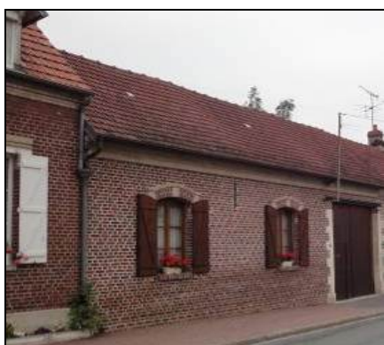
Linteau en briques et pierre en forme d'arc
