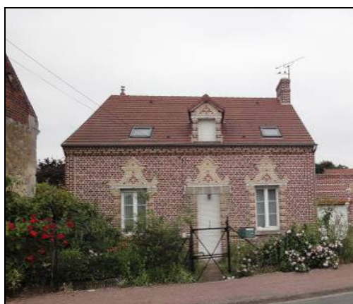
Construction en briques avec modénature riche
