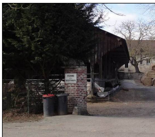
Photographie du bâtiment accueillant l'élevage de bovins
