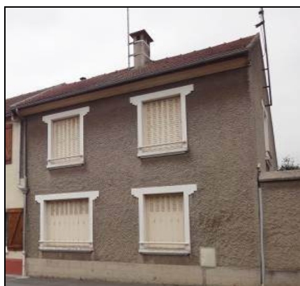
Construction avec façade recouverte de crépi
