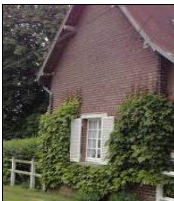
Division en 8 carreaux par ouvrant Volet persienné sur tout le volet
