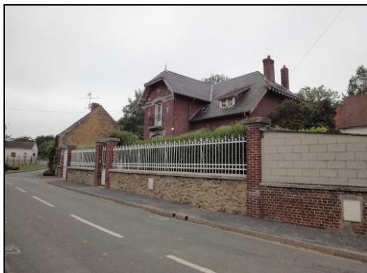
Toiture en ardoise à plusieurs pans / Lucarne rampante
