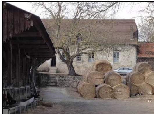
Construction en pierres avec escalier d'accès
