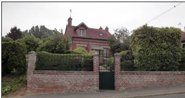
Construction ancienne implantée en retrait avec mur de clôture en briques et porte piétonne
