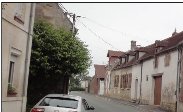
Toiture en tuiles plates / Lucarne à la capucine
