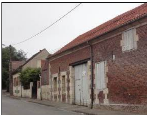
Construction en briques et chaînage en pierre Porte charretière et porte piétonne
