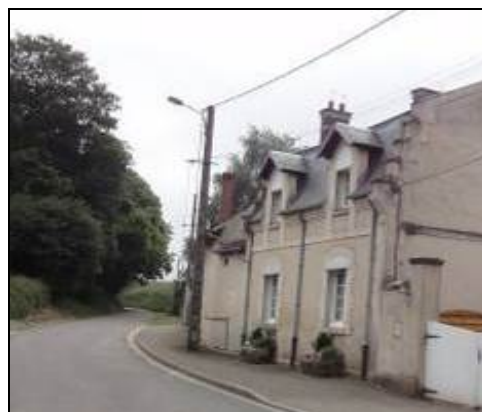
Toiture en ardoise / Lucarne pendante
