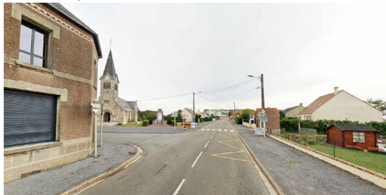
Vue sur les abords actuels de l'église et l'arrêt d'autocars des scolaires peu sécurisé sur la RD142.
