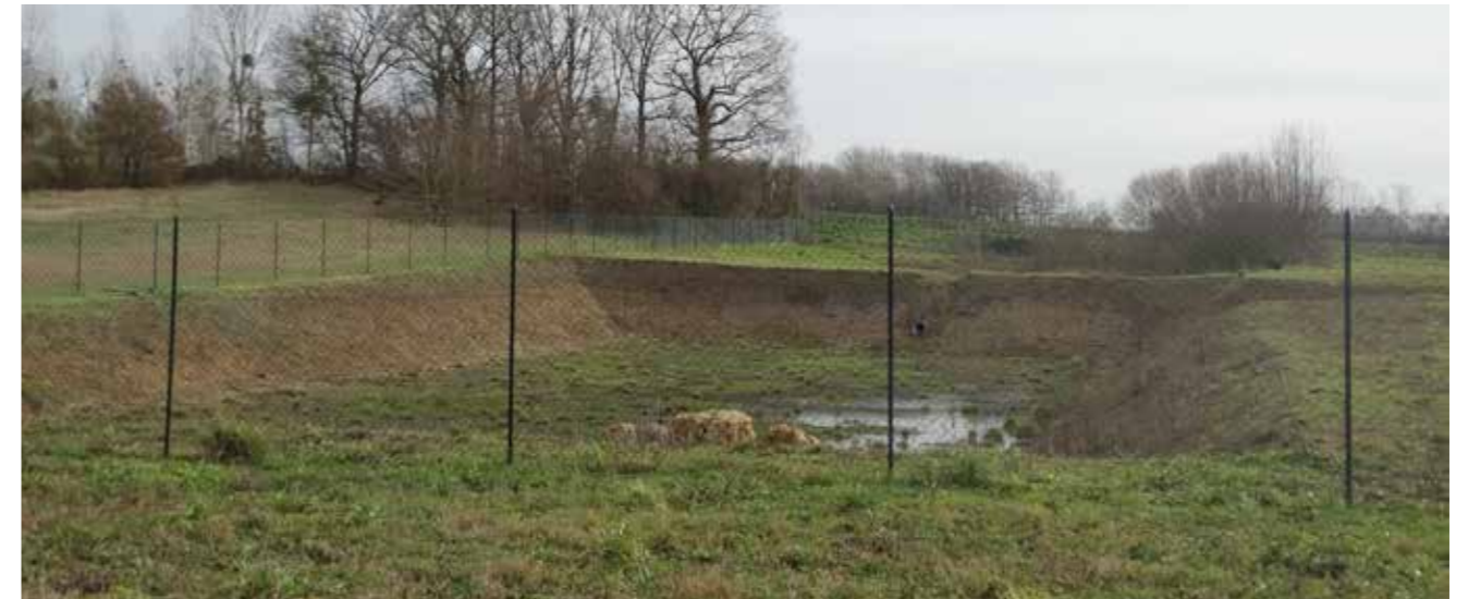
Vue sur le bassin de régulation des eaux pluviales aménagé sur l'emprise communale en face de la mairie.
