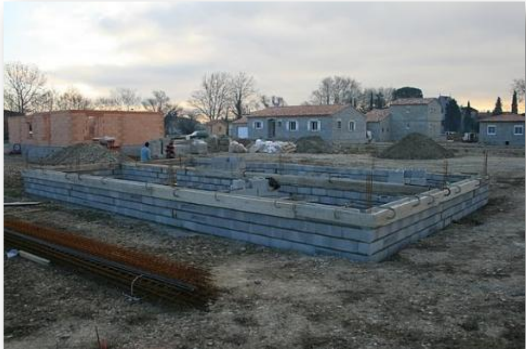
Figure 15 : Construction d'un vide sanitaire
